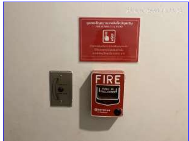
รูปที่ 2.19 alarm bell and manual
